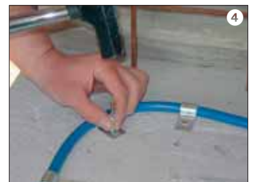
WATERPROOF X®1 muss plan aufliegen.
