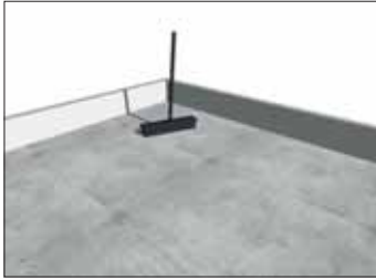
Herstellen einer Tragschicht nach DIN 1045-2 Verdichtetes, sauberes Planum Betontragschichten nach DIN EN 206-1 und DIN 1045-2
