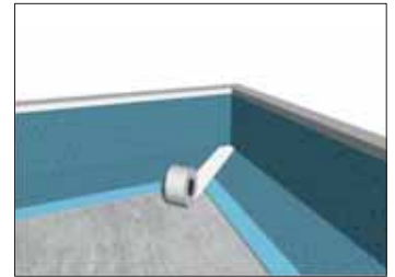
Zusätzliche Verklebung des Eckbereiches mit Polyfleece SX® 1000 -Klebeband
