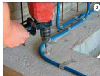
Verlegen und befestigen.
