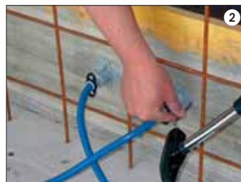
Aufnageln des Superpacker an die Schalung.
