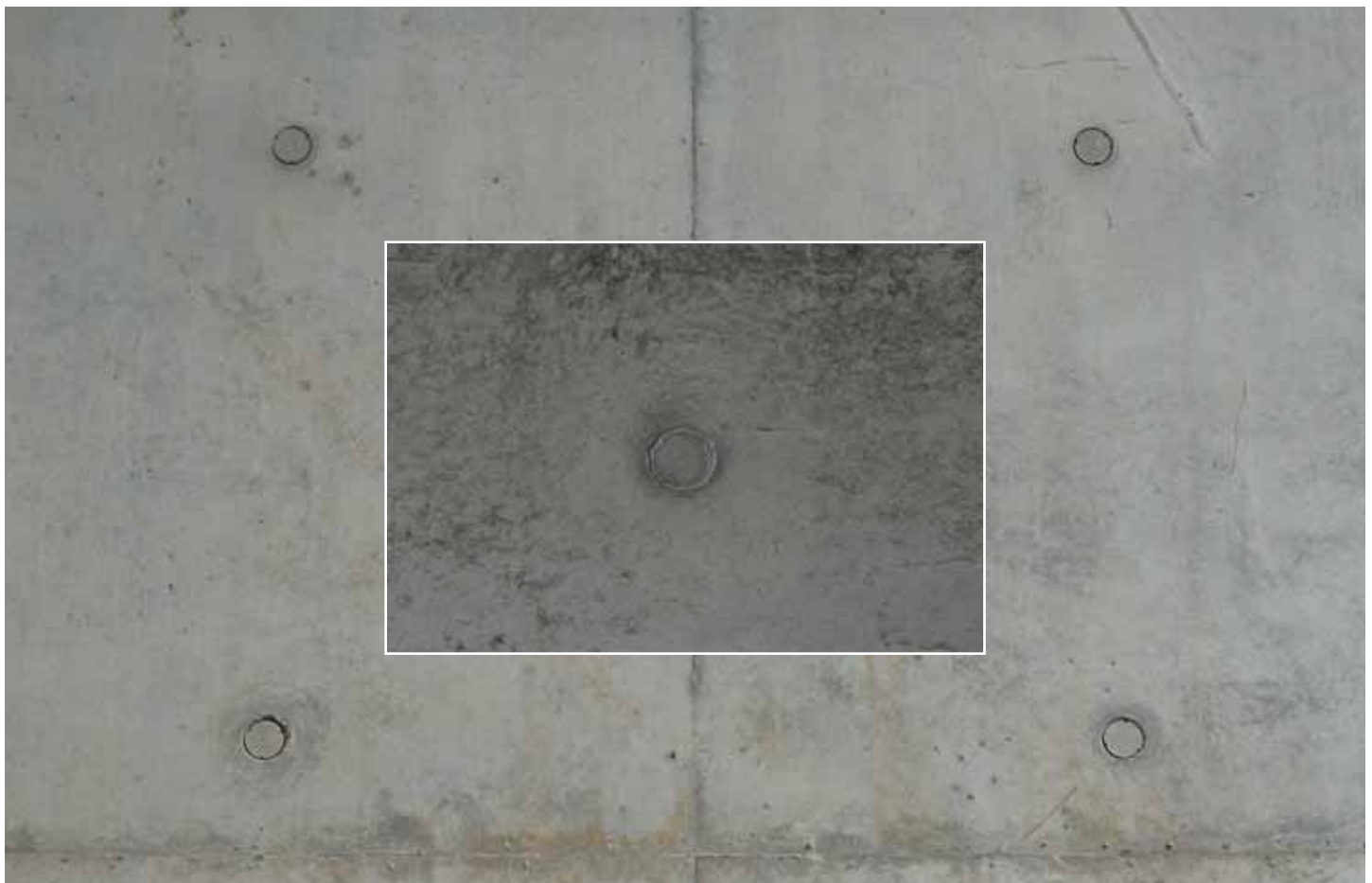
1) Einbringen des Klebstoffs in die konische Öffnung
