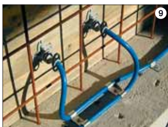
Fertig verlegter Injektionsschlauch WATERPROOF X®1
