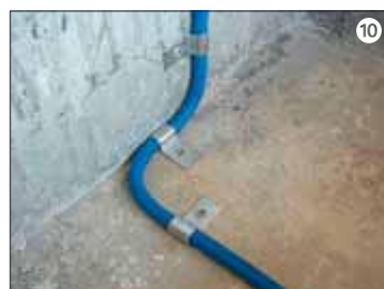
Verlegung im Eckbereich.
